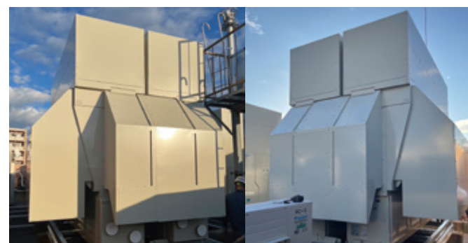
防雪ネット付き防音システム ヘキサゴンフォース5台連結用 防音壁+防音ダクト+防雪ネットがセットになった特注品です。
