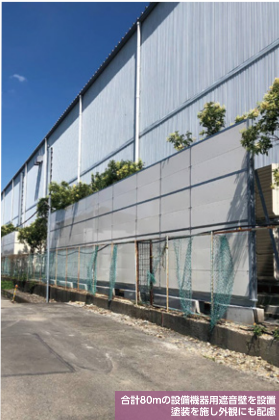
狭小なスペースに高さ3mの遮音壁を設置
