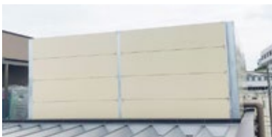
▲ 京都府某現場
