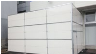
▼ 札幌市内某現場
