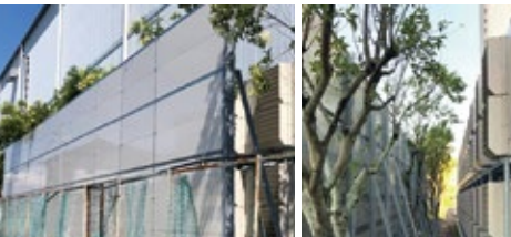
▼ 静岡県内某現場
