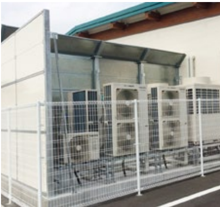
▼ 大分県内某現場
