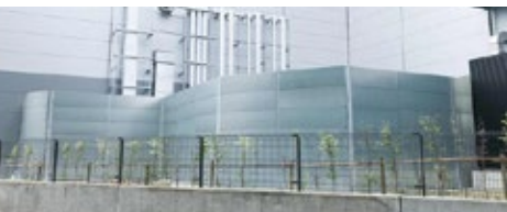
▲ 大阪府某現場
