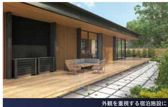
高級住宅の室外機設置場所に
