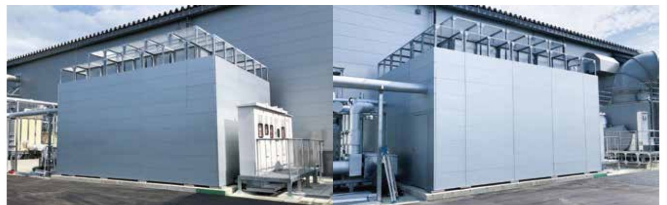
防雪ネット付き防音システム ヘキサゴンフォース5台連結用
