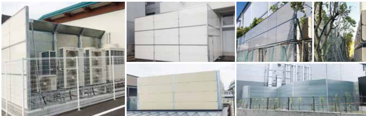
▲京都府某現場
