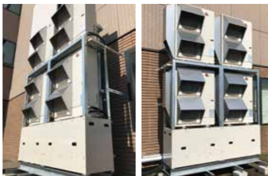
▲ 2段目室外機下部にはヒーター付きドレンパンも組み込み
