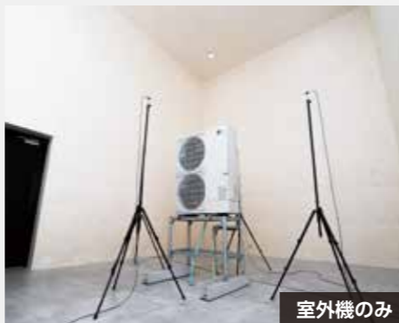
防音システム設置
