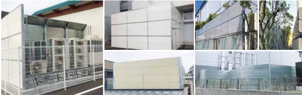
▲京都府某現場
