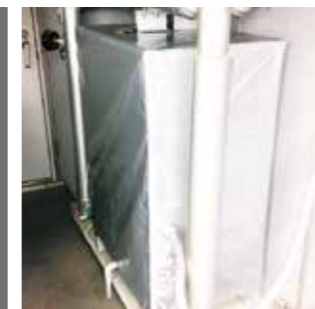
屋外設置防水シート
