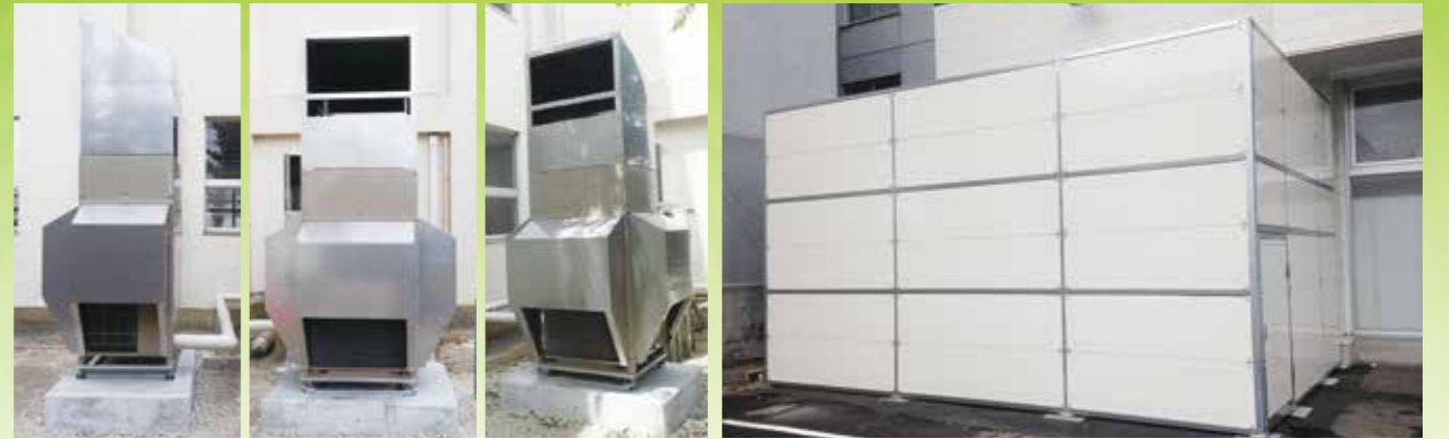
防音防雪フード 背面側薄型仕様 吸込側の防音防雪フードの奥行を変更し、スペースを確保しました。
