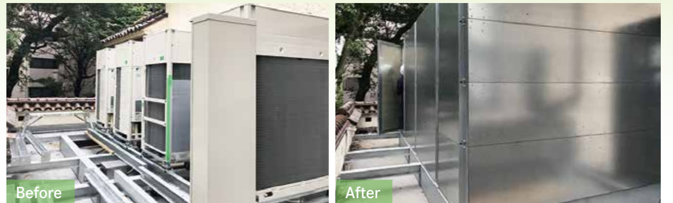
防音防雪フード 背面側薄型仕様 吸込側の防音防雪フードの奥行を変更し、スペースを確保しました。
